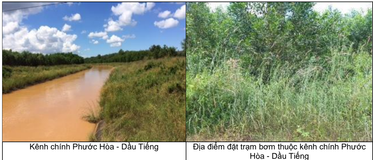
Hình I-4: Ảnh thực địa tiểu dự án 2, tỉnh Bình Phước.
