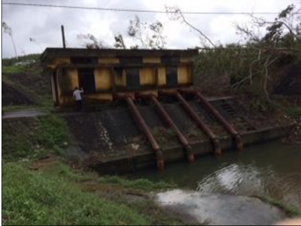
Trạm bơm Bbm5 sẽ được nâng cấp.
