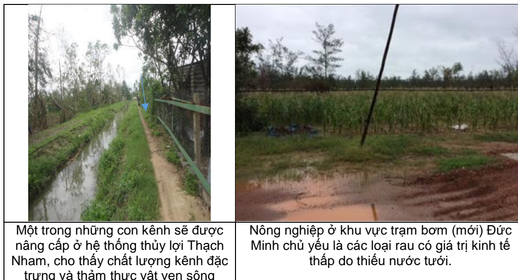
Hình III-6: Ảnh hiện trường, tiểu dự án Hệ thống thủy lợi Núi Ngang và Thạch Nham, tỉnh Quảng Ngãi.
