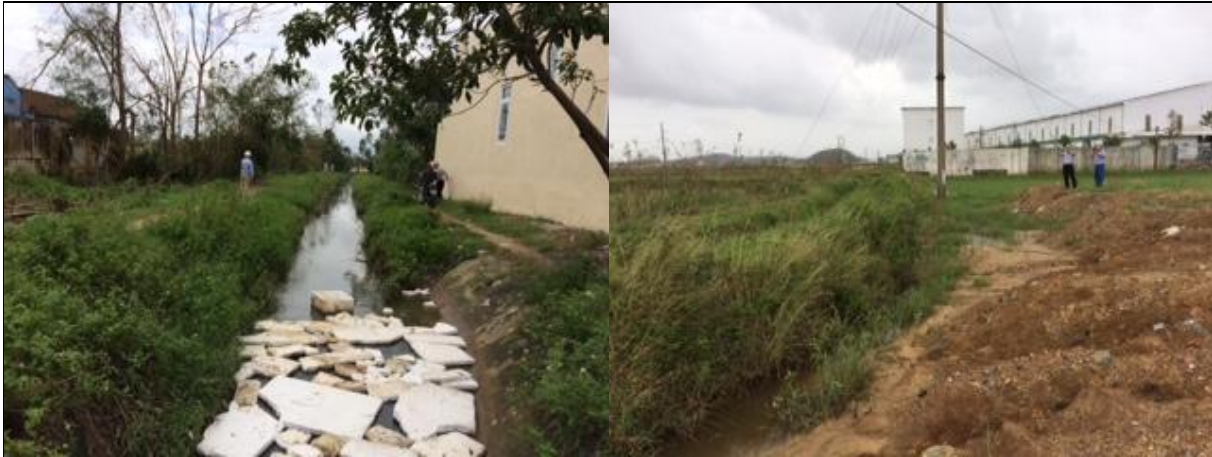
Kênh N6 sẽ được nâng cấp.
